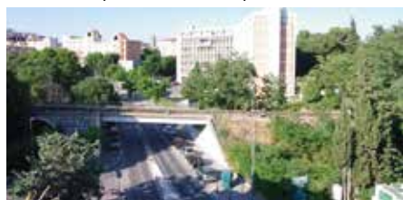
Pont Schuman avant travaux
