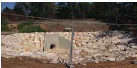
Ouvrage hydraulique sous les voies - Passage à niveau d'Aix
