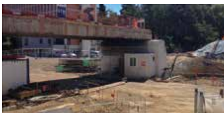
Pont Schuman durant travaux
